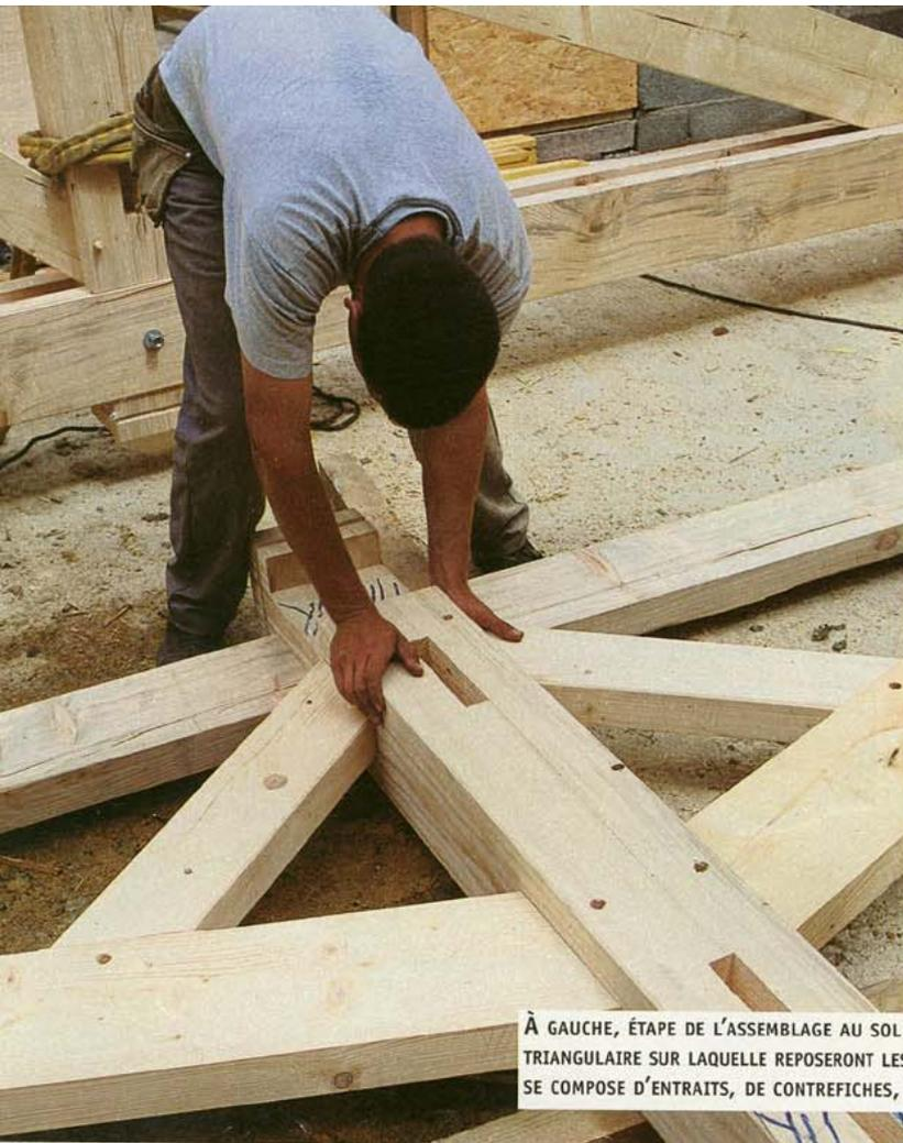
À GAUCHE, ÉTAPE DE L'ASSEMBLAGE AU SOL DE LA FERME, CETTE PIÈCE DE BOIS TRIANGULAIRE SUR LAQUELLE REPOSERONT LES PIÈCES DE LA CHARPENTE. ELLE SE COMPOSE D'ENTRAITS, DE CONTREFICHES, D'ARBALÉTRIERS ET D'UN POINÇON.
