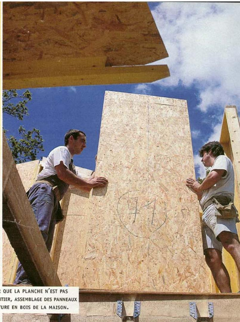
À GAUCHE, TONY YOU EN TRAIN DE VÉRIFIER QUE LA PLANCHE N'EST PAS GAUCHIE (GONDOLÉE). À DROITE, SUR LE CHANTIER, ASSEMBLAGE DES PANNEAUX DE TRIPLY QUI SERVENT À RIGIDIFIER L'OSSATURE EN BOIS DE LA MAISON.
